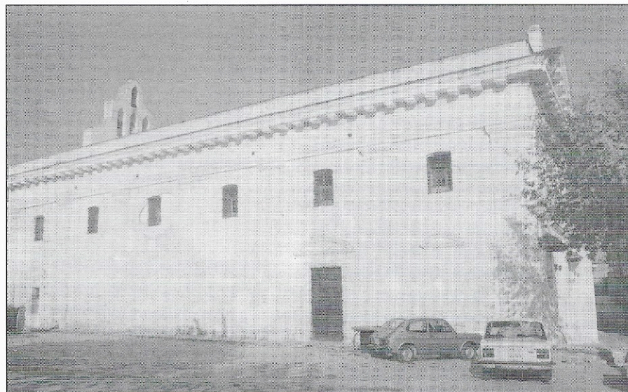
Fachada lateral de la recoleta Iglesia de la Divina Pastora, donde se puede observar la pequeña puerta lateral que posteriormente fue ampliada.
